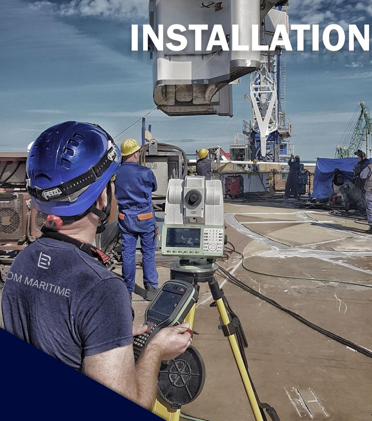
Quando l'installazione richiede un livello di precisione superiore, con tempi di produzione limitati o circostanze pericolose, i moduli prefabbricati, le parti o i tubi sono dimensionati, controllati e segnalati per ridurre rischi, sollecitazioni interne ed eventualmente essere conformi alla Classe.
